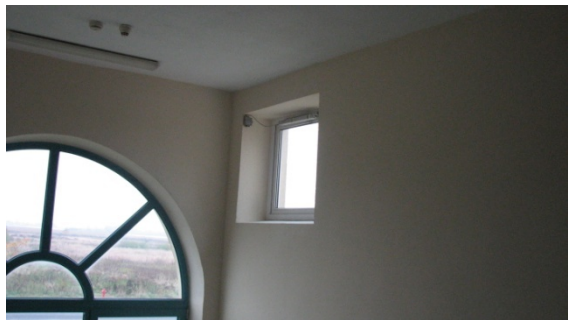
Zdjęcie nr 13. Widok okna oddymiającego na klatce schodowej w budynku nr 2.
