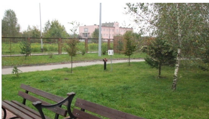
Zdjęcie nr 8. Widok hydrantu zlokalizowanego w pobliżu kotłowni.
