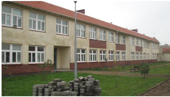
Zdjęcie nr 6. Widok elewacji zachodniej budynku nr 7.
