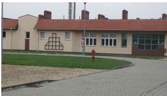
Zdjęcie nr 9. Widok hydrantu zlokalizowanego w pobliżu budynku nr 13.
