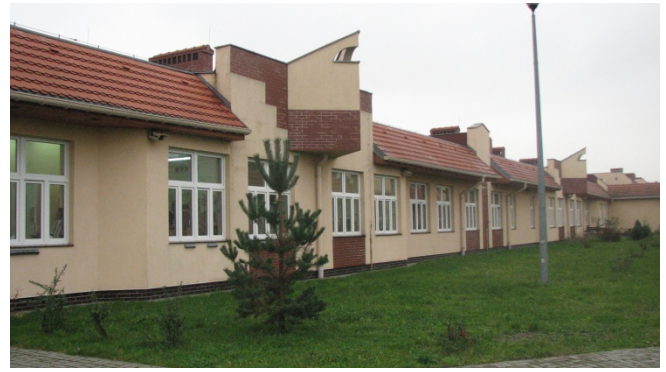
Zdjęcie nr 7. Widok elewacji wschodniej budynku nr 8.
